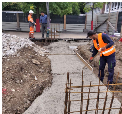
► Ecole élémentaire Michelet : Coulage des fondations de la nouvelle structure d'accueil périscolaire
