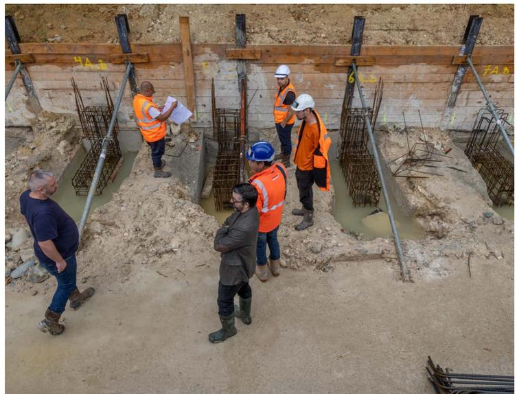
► Pose des micropieux et des ancrages des parois du mur de soutènement
